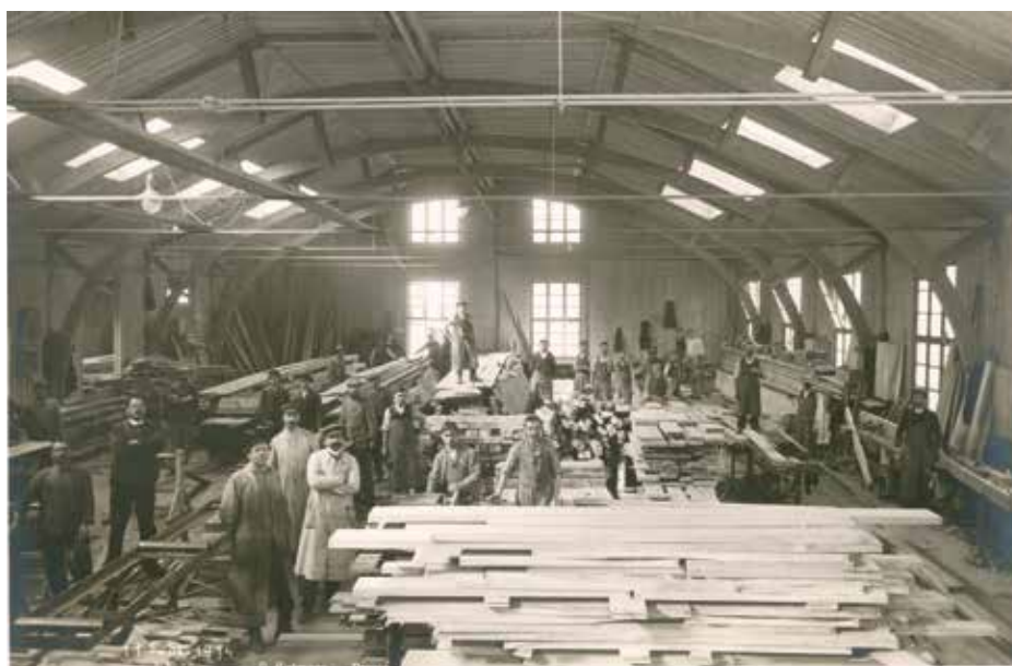
Blick in die Schreinerei auf dem Baugelände in Dornach, Foto Otto Rietmann, 1914
